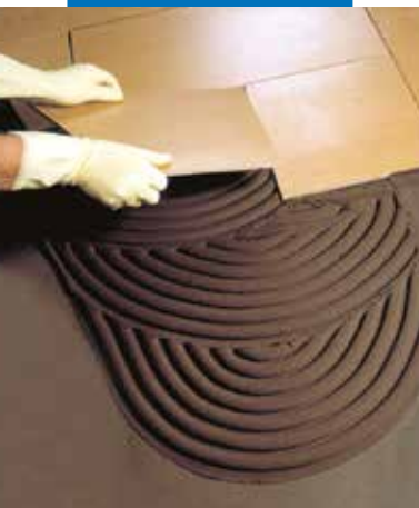
Porceliano plytelių dengimas ant plokštės, hidroizoliuotos su Mapelastic
