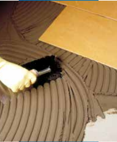
Elastorapid paskleidimas ant cementinių grindų rautyta mentele
