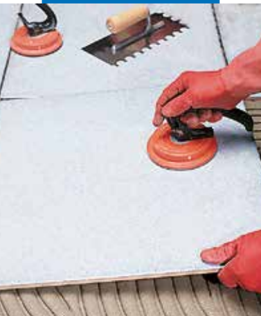
Didelio formato plytelių klijavimas
