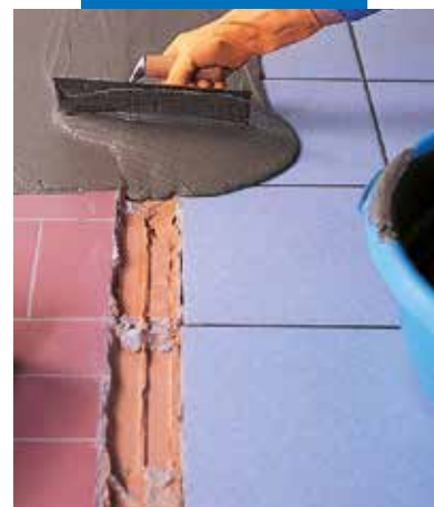
Esamų grindų išlyginimas naudojant Adesilex P4
