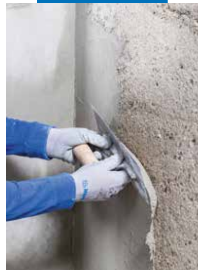
Planitop Smooth & Repair R4 užtepimas glaistykle
