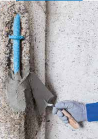
Planitop Smooth & Repair R4 užtepimas mentele
