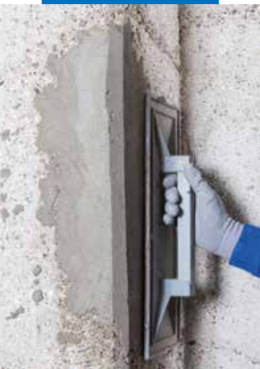
Planitop Smooth & Repair R4 paviršiaus užtrynimas
