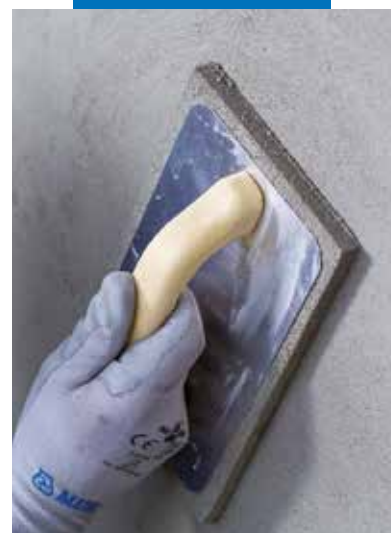
Planitop Smooth & Repair R4 paviršiaus užtrynimas
