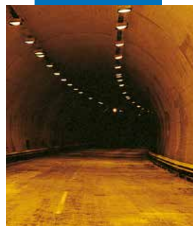
Balto Planiseal 88 užpurškimas ant greitkelio tunelio sienų
