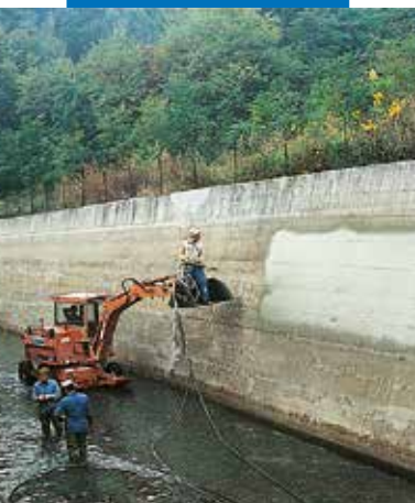
Planiseal 88 užpurškimas ant hidroelektrinės kanalo sienų
