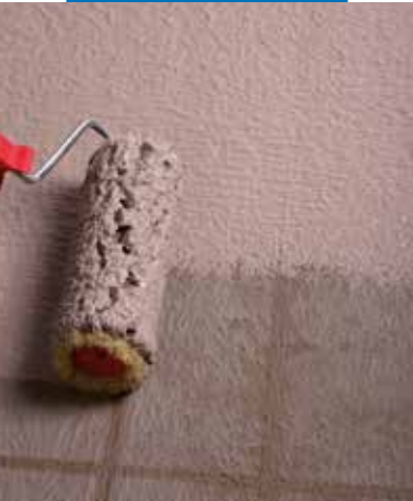
Hidroizoliacijos tepimas voleliu
