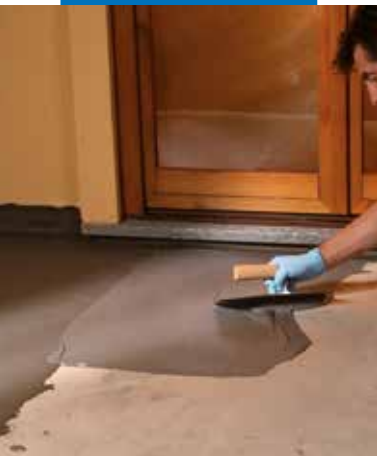
Hidroizoliacijos tepimas mentele
