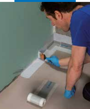
Mapeband PE 120 juostos įrengimas ant horizontalaus paviršiaus naudojant Mapegum WPS
