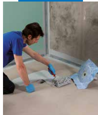
Drain Vertical elemento įrengimas naudojant Mapegum WPS
