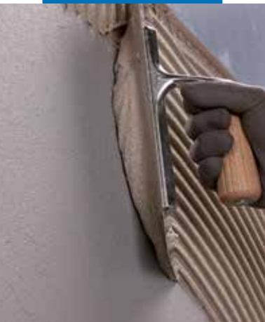
Grindų dangos įrengimas naudojant Ultramastic III
