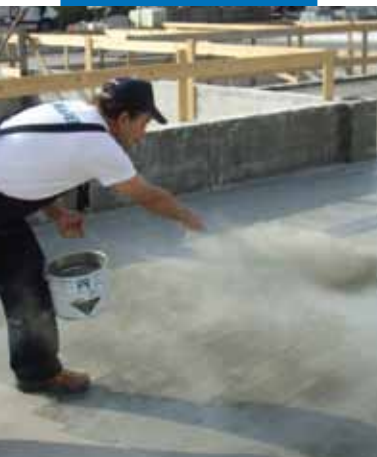
Sprinkling Quarzo 0.5 on fresh Primer SN
