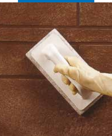
Siūlių valymas naudojant Scotch-Brite® (kai glaistas dalinai išdžiūvęs)
