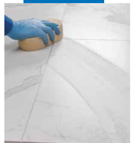
Grindų apdaila su kieta celiuliozine kempine
