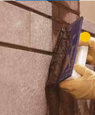
Ultracolor Plus paskleidimas ant sienos naudojant guminę mentelę
