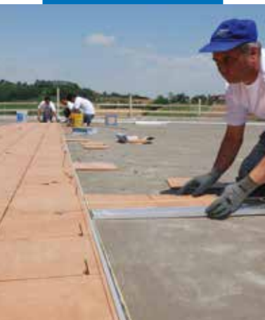
Keraminių plytelių klojimas naudojant "Kerabond" ir "Isolastic"
