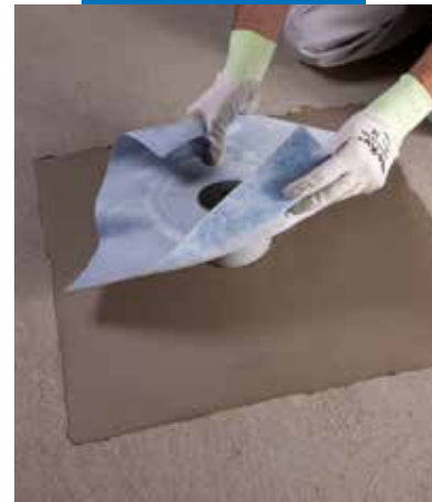
“Drain Vertical” elemento įrengimas ant “Mapelastic”
