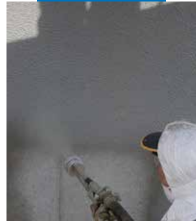
"Mapelastic" purškimo ant viaduko konstrukcijų pavyzdys
