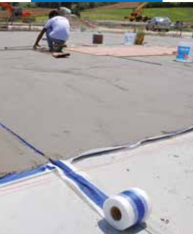
Išlyginamojo sluoksnio hidroiziacija naudojant "Mapelastic" ir "Mapeband"
