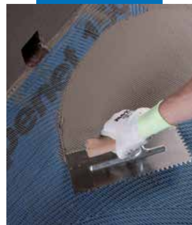
“Mapelastic” dengimas ant “Mapenet 150”
