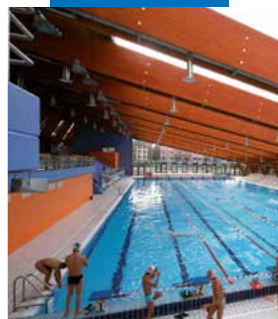
Baseinas su "Mapelast" hidroizoliacija: "Scarioni" laisvalaikio centras - Milanai - Italija
