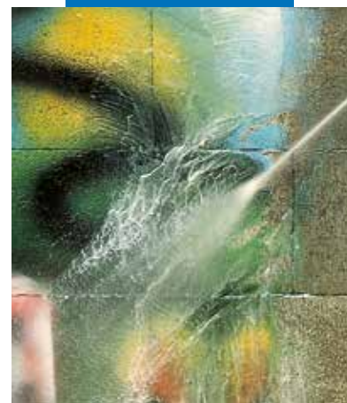
Valymas naudojant aukšto slėgio vandens srovę
