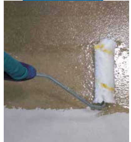
“Terrazzo alla veneziana” effect. Application of Mapefloor I 910
