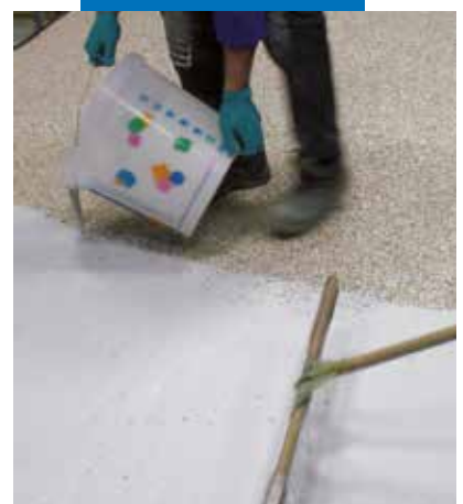
Ultratop panaudojimas ant sukietėjusio paviršiaus iš natūralaus užpildo + Mapefloor I 910
