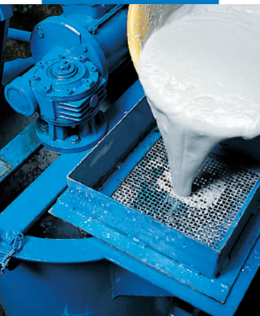
Injektavimo siurblio Mape-Antique I užpildymas su
