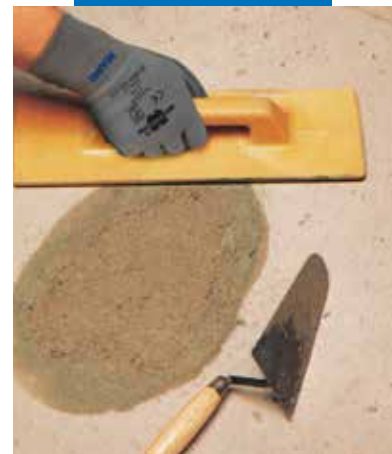
Grindų remontas: galutinis lyginimas
