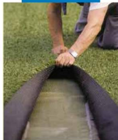
Sintetinės žolės dangos montavimas naudojant Adesilex G19 - S.Siro Stadionas - Milanas - Italija
