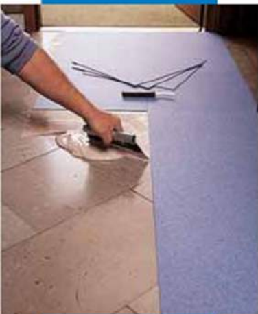
PVC dangų klojimas ant neįgeriančių paviršių naudojant Adesilex G19
