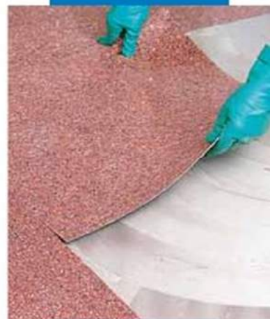
PVC dangos montavimas naudojant Adesilex G19
