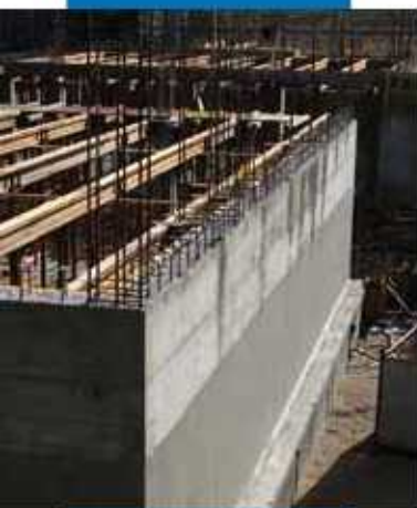
Pamatų konstrukcijų hidroizoliavimas naudojant Mapelast ic foundation
