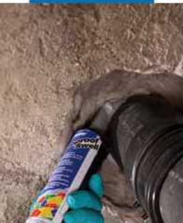
Tuštumos aplink vamzdį sandarinimas naudojant Mapeproof Swell
