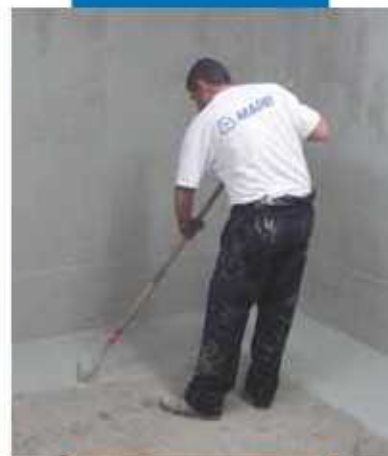
Mapelastic foundation užtepimas voleliu siekiant apsaugoti konstrukciją nuo neigiamo vandens slėgio
