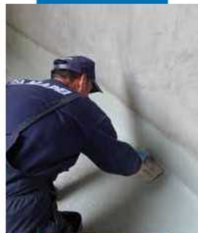
Mapelastic foundation užtepimas mentele siekiant apsaugoti konstrukciją nuo neigiamo vandens slėgio
