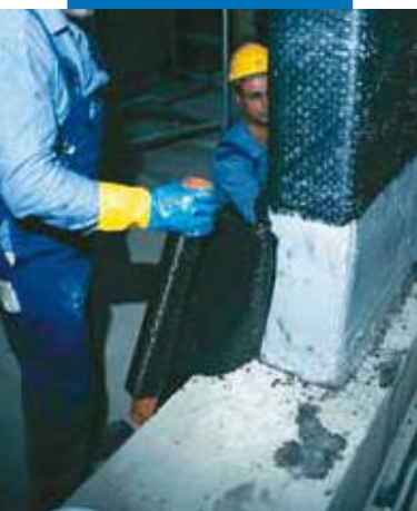
MapeWrap klijavimas ant gelžbetonio konstrukcijos
