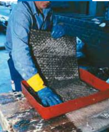
MapeWrap C impregnavimas rankiniu būdu
