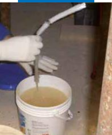
MapeWrap FIOCCO dalies impregnavimas
