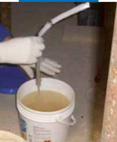
MapeWrap FIOCCO dalies impregnavimas
