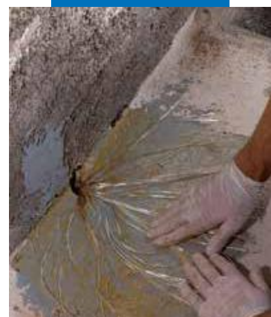
Išskleistas MapeWrap FIOCCO galas
