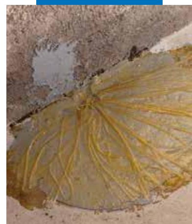
MapeWrap FIOCCO impregnavimas
