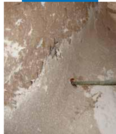
MapeWrap FIOCCO įdėjimas į skylę
