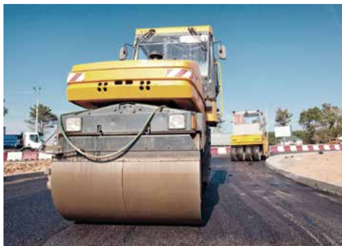
Pakloto sluoksnio tankinimas ir užbaigimas.
