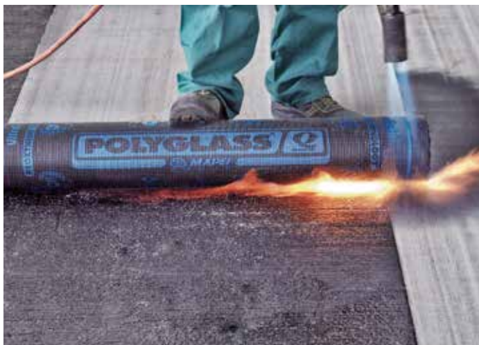
"REOXTHENE" produktų linijos membranos prilydimo procesas.
