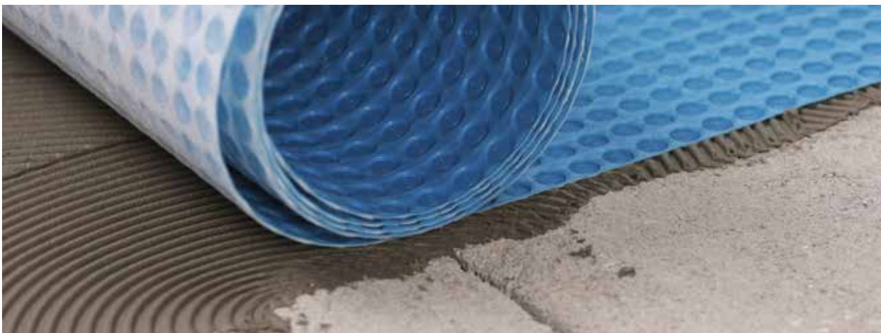
Montering av Mapeguard UM 35 på sementbasert avrettingslag med kontrollfuger.
