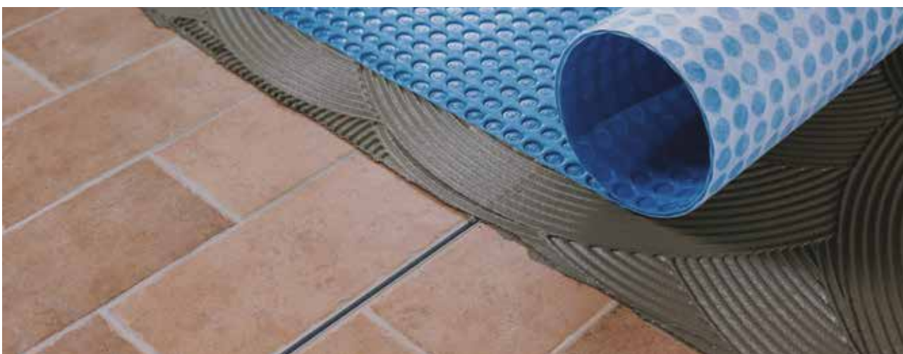
Legging av Mapeguard UM 35 på eksisterende keramikkulv med ekspansjonsskjøter.
