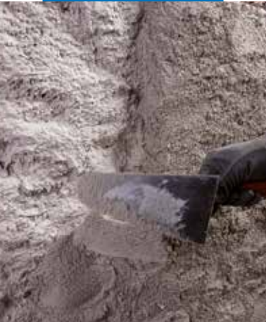
Mape-Antique MC užtepimas ant Mape-Antique Rinzafo
