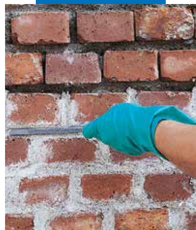
Mūro siūlių, užtaisytų su Mape-Antique MC, užbaigimas
