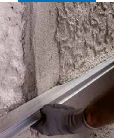
Mape-Antique MC išlyginimas su trapecine liniuote
