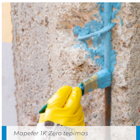
Mapefer 1K Zero tepimas ant viaduko armatūros strypų
