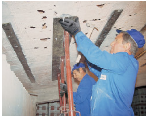
Metalinių/plieninių stiprinimo juostų kljavimas ant laikančiųjų konstrukcijų
