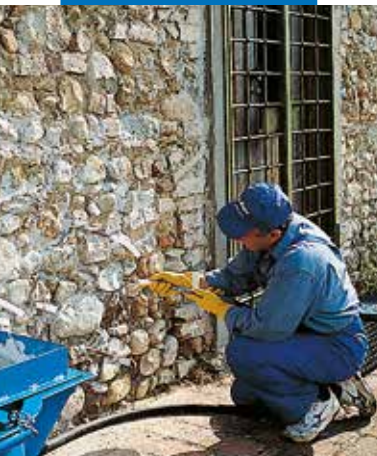
Konsoliduojanti injekcija su Mape-Antique I
