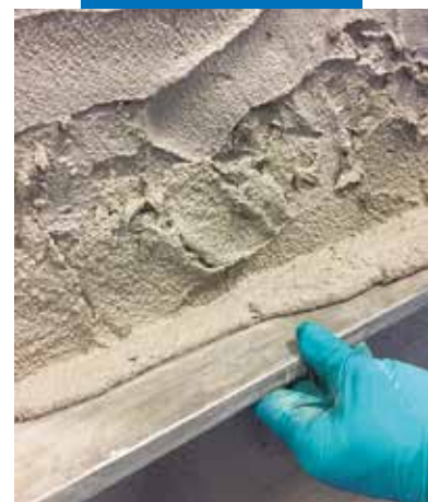
PoroMap Deumidificante išlyginimas trapecine liniuote
