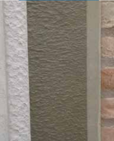
Poromap Rinzaffo Plus sluoksnio įrengimas ant Mapelastic Foundation sluoksnio garų užtvarami sukurti
