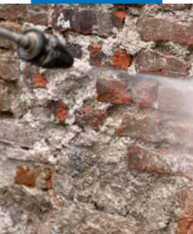
Mūro plovimas vandens srove
