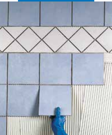
Vieno degimo plytelių įrengimas ant gipso kartono sienos
