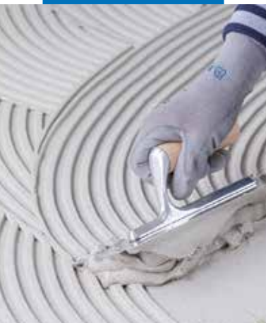
Adesilex P9 baltos spalvos platinimas
