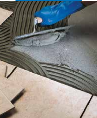
Instalacija vienkartinė plytelė ant grindų
