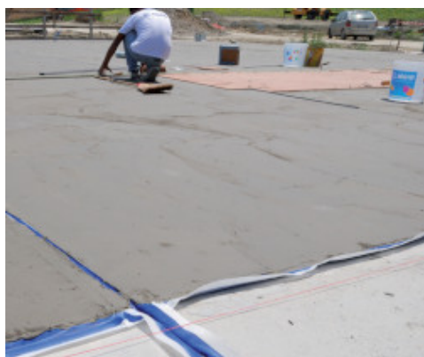
Hidroizoliacinio sluoksnio įrengimas su Mapelastic ir Mapeband
