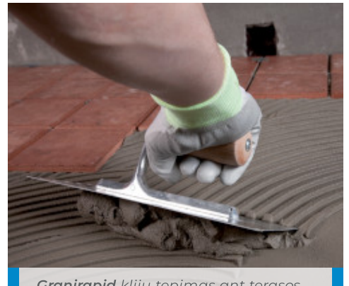
Granirapid klijų tepimas ant terasos, kurioje įrengta Mapelastic hidroizoliacija
