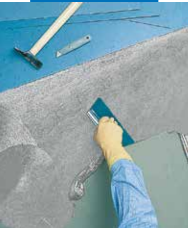
Ultrabond Eco V4 SP Conductive užtepimas
