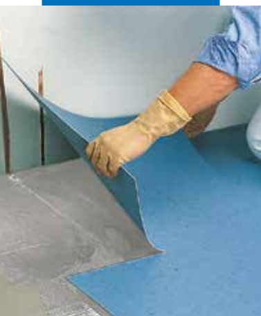
Elektrai laidžių PVC plytelių klijavimas su Ultrabond Eco V4 SP Conductive
