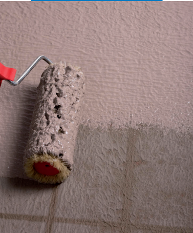
Hidroizoliacijos tepimas voleliu
