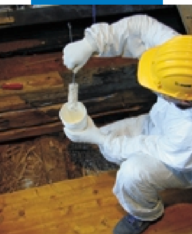
Application phase of Mapewood Primer 100
