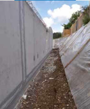
Konstruktinių siūlių laikančiose sienose sandinimas
