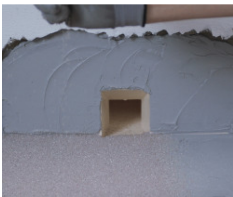
Vamzdžių hidroizoliacija iš priekio
