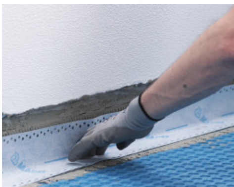
Hidroizoliacija per visą perimetrą su Mapeband Easy juosta, priklijuota su Mapeguard WP Adhesive klijais
