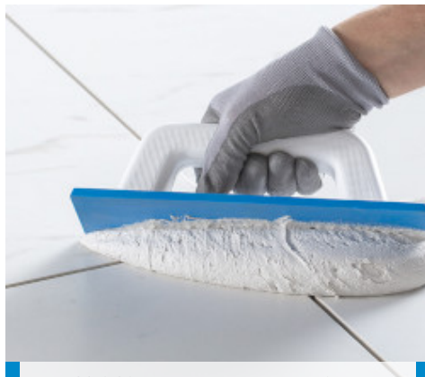
Paskleiskite Kerapoxy Easy Design su Mapei glaistykle
