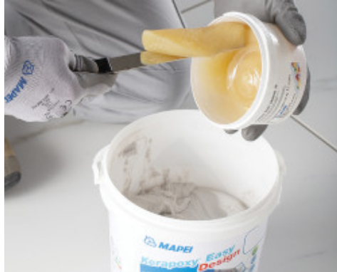
Supilkite kietiklį (B komponentą) į indą su A komponentu
