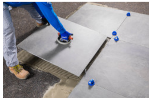
Paskirstykite klijus ant Mapesonic CR ir priklijuokite naują grindų apdailą
