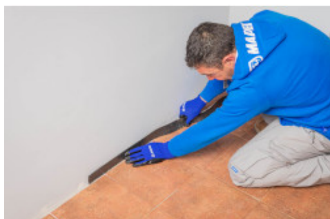
Priklijuokite Mapesonic Strip juostą aplink patalpos perimetrą
