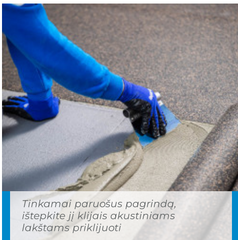
Išvyniokite Mapesonic CR ruloną ant pagrindo, kad būtų sukurta garso izoliacija
