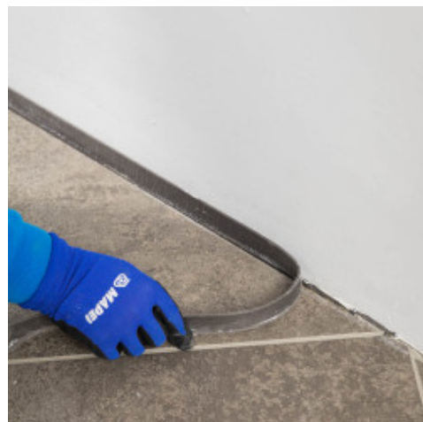
Paskirstykite klijus ant Mapesonic CR ir priklijuokite naują grindų apdailą
