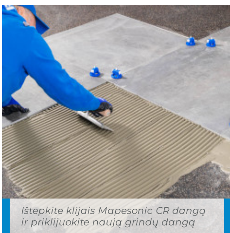
Tinkamai paruošus pagrindą, iššepkite jį klijais akustiniams lakštams priklijuoti
