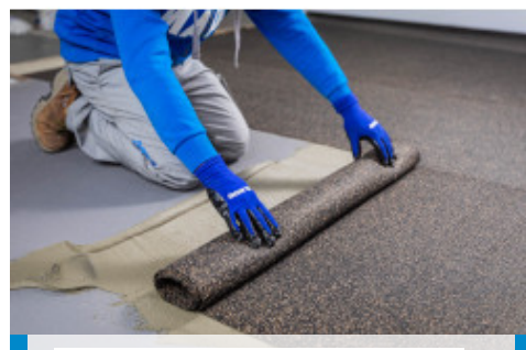
Išvyniokite Mapesonic CR ruloną ant pagrindo, kad būtų sukurta garso izoliacija
