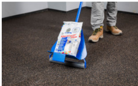
Lyginkite paviršius standžiu voleliu arba plokščia mentele, pradėdami nuo centro ir judėdami link krašto
