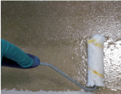
„Terrazzo alla veneziana“ mozaikinio betono efektas Mapecoat Universal Thix užtepimas
