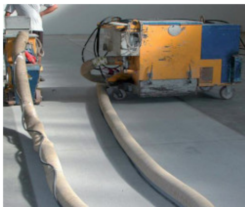
Pagrindo apdirbimas srautinio šratavimo būdu
