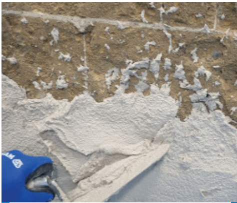
Mape-Antique NHL ECO Risana užtepimas mentele ant tufo pagrindo
