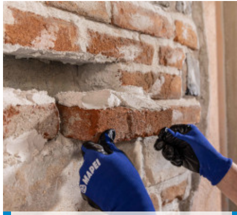
Plytų mūro atstatymas
