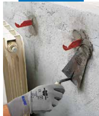
Radiatorių tvirtinimo elementų remontas naudojant Lampocem
