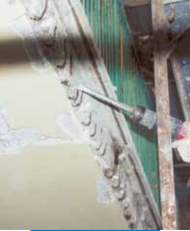
Balkono gelžbetoninės plokštės remontas. Pagrindo paruošimas
