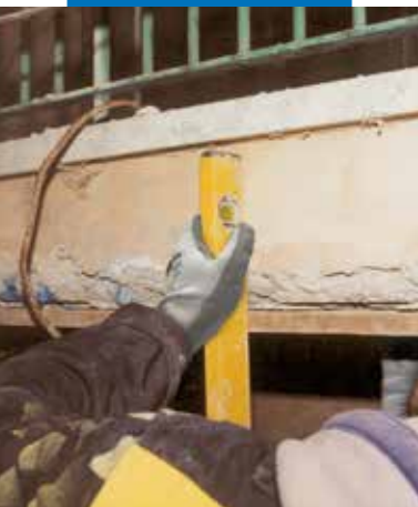
Balkono gelžbetoninės plokštės remontas. Medinių klojinių įrengimas.
