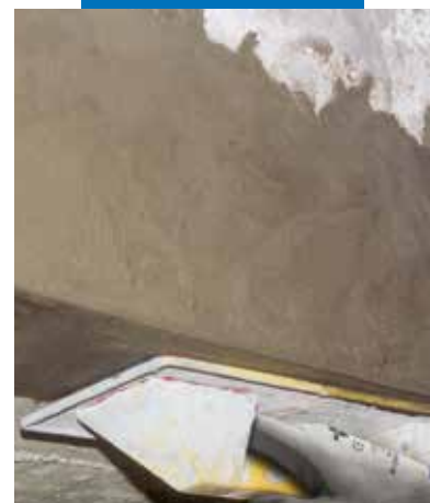
Gelžbetoninės sijos remontas.
