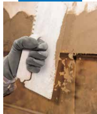
Balkono gelžbetoninės plokštės remontas. Apdaila.
