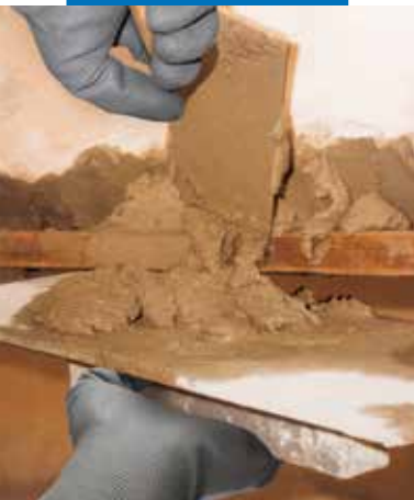
Balkono gelžbetoninės plokštės remontas. Planitop 400 remonto mišinio naudojimas.
