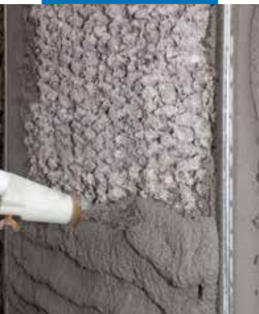
Mapegrout 430 naudojimas purškimo būdu
