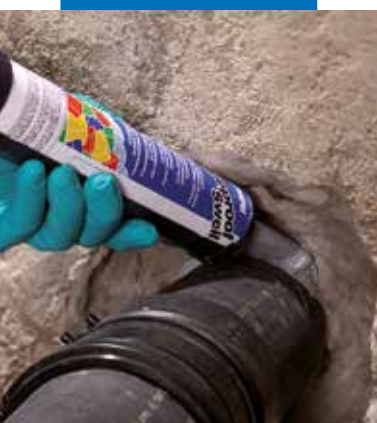
Vamzdžio sandarinimas su Mapeproof Swell
