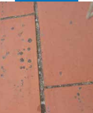
Terakotos grindys, kurias reikia sutvarkyti prieš įrengiant Aquaflex Roof
