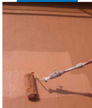
Aquaflex Roof tepimas ilgaplaukiu voleliu
