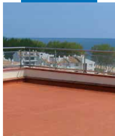
Grindinio plytelės hidroizoliuotos su Aquaflex Roof
