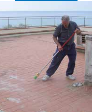
Pagrindo valymas prieš įrengiant Aquaflex Roof
