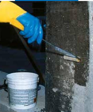
MapeWrap 31 užtepimas voleliu ant dar šlapio MapeWrap 11 ar MapeWrap 12 paviršiaus
