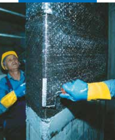
Audinio prispaudimas MapeWrap audiniui skirtu voleliu, kad MapeWrap 31 gerai įsigertų į audinį
