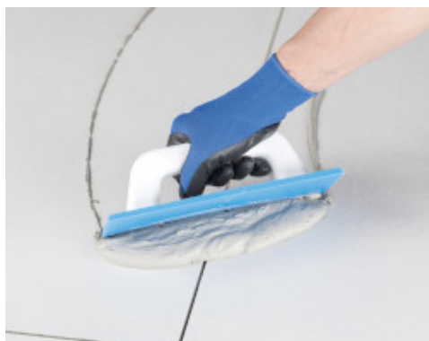
Ultracolor Plus skleidimas ant akmens masės grindų plytelių su gumine glaistykle
