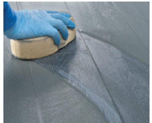
Grindų valymas kieta celiuliozine kempinėle
