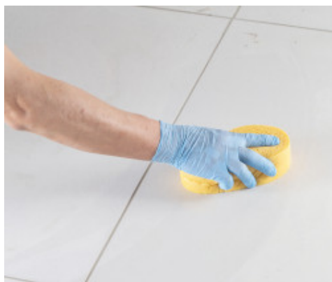
Siūlių valymas ir apdaila su kieta celiuliozine kempinėle
