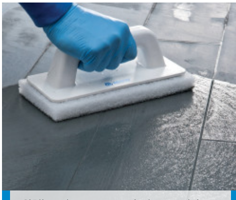
Siūlių valymas nuo grindų, naudojant Scotch-Brite® (kai glaistas dalinai išdžiūvęs)
