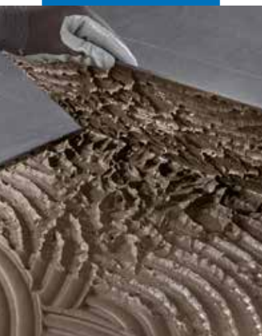
Tikrinama ar pilnai užteptos plonasluoksnės akmens masės plytelėse
