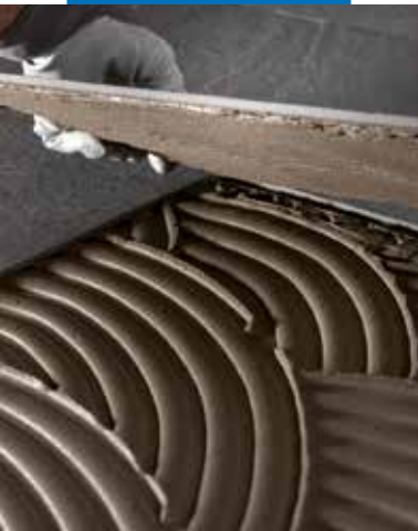
Plonasluoksnių akmens akmens masės plytelių įrengimas
