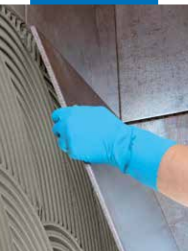
Didelio formato plytelių klijavimas ant sienos
