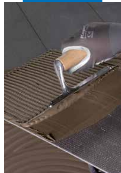
Klijų paskleidimas ant klijuojamosios plytelės pusės
