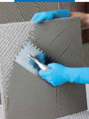
Klijų paskleidimas ant klijuojamosios plytelės pusės
