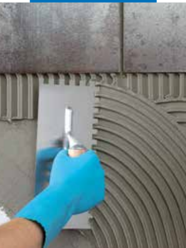
Ultralite S1 klijų užtepimas ant sienos dantyta glaistykle
