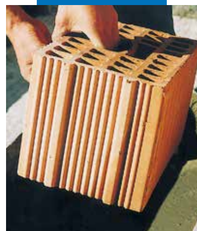
Betoninio blokelių sutepimas naudojant Adesilex P4
