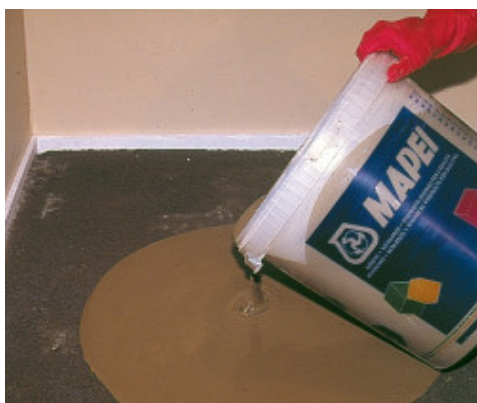
Novoplan 21 pastos tepimas ant pagrindo
