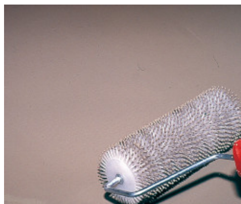
Išlietos Novoplan 21 dangos braukimas dygliuotu voleliu
