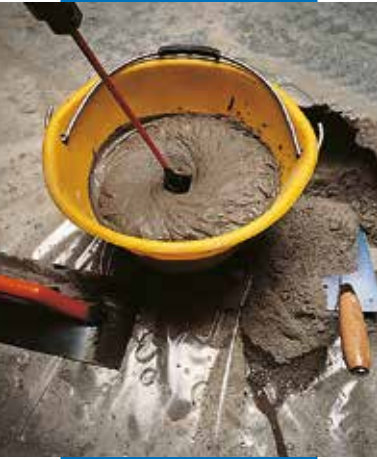
Nivorapid išmaišytas mechaniniu maišytuvu
