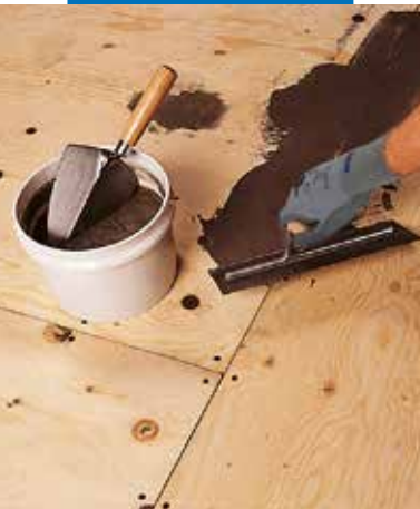
Faneros plokščių tarpų glaistymas naudojant Nivorapid + Latex Plus
