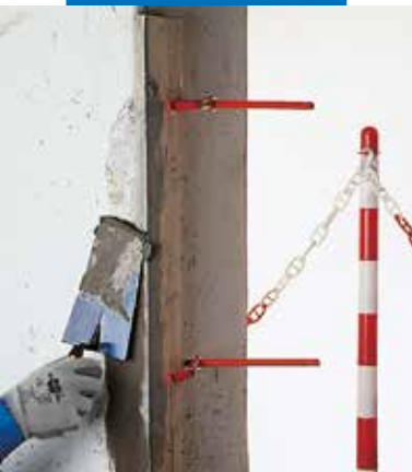
Vertikalios plokštumos glaistymas naudojant Nivorapid
