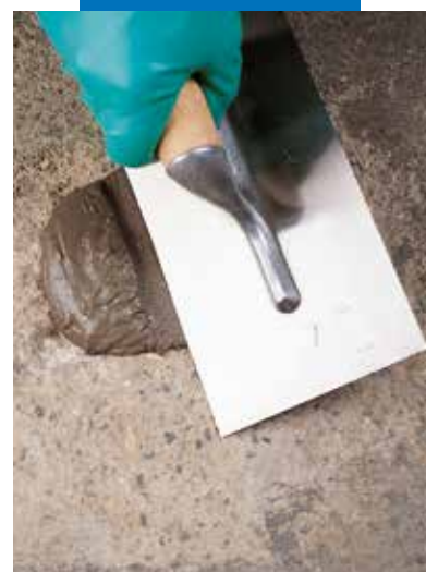
Horizontalių plokštumų remontas naudojant Nivorapid
