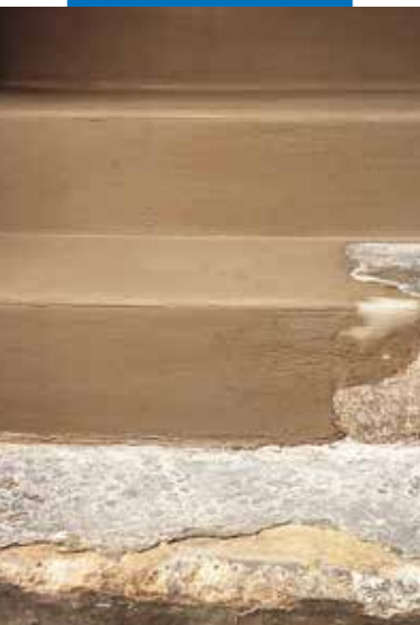
Laiptų pakopų remontas naudojant Nivorapid
