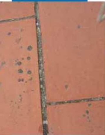
Senos terracotta tipo grindys reikalaujančios paruošimo prieš naudojant Aquaflex roof
