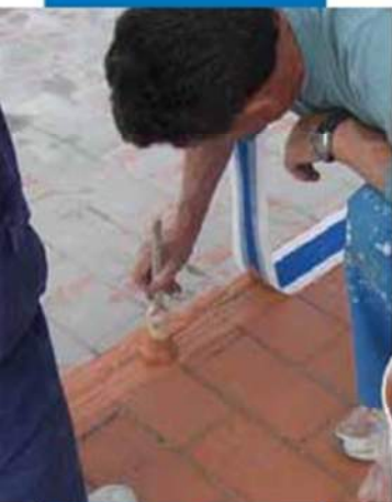
Deformacinės siūlės hidroizoliavimas su Mapeband ir fiksavimas naudojant Aquaflex Roof
