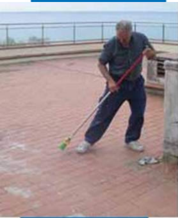
Pagrindo valymas prieš Naudojant Aquaflex Roof
