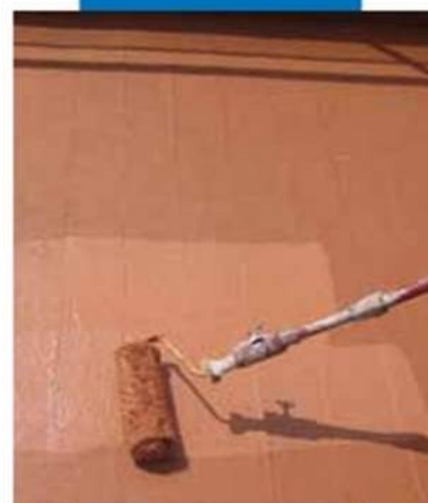
Aquaflex Roof tepimas naudojant ilgaplaukį volelį
