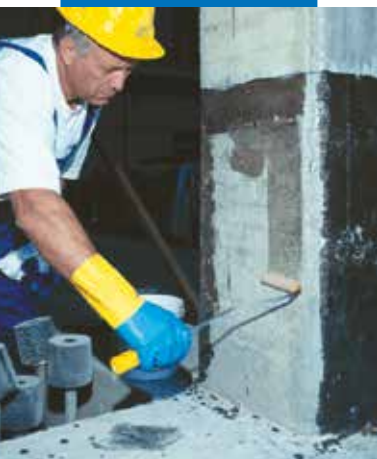
Pirmo MapeWrap Primer 1 sluoksnio tepimas
